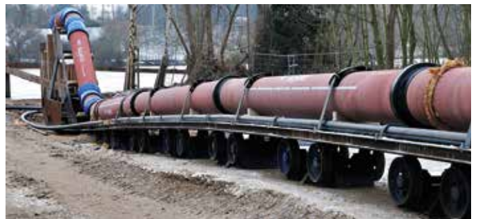
Förberedelser för installation av en kulvertledning i ZM-utförande.
