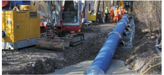
Schachtfritt ledningsbyggande med ZM-belagda rör.
