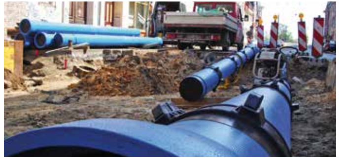
Effektiv totallösning vid traditionell ledningsdragning med segjärnsrör.
