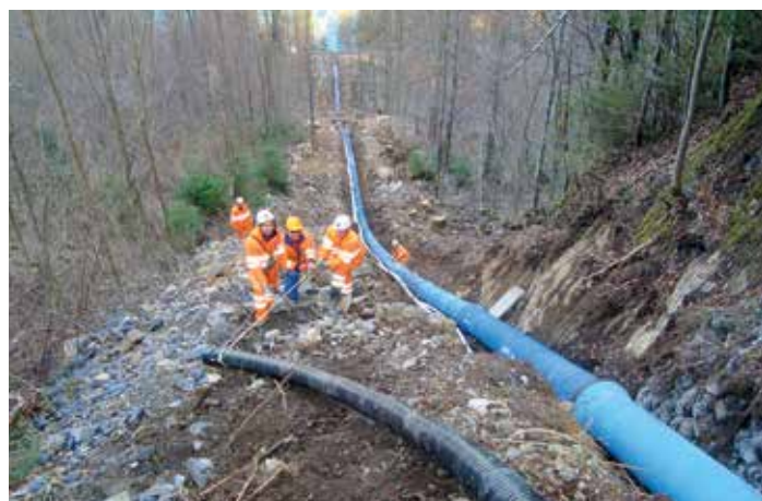
Fiberarmeradabetsong-beläggning (ZM-beläggning) innebär att inga fyllnadsmassor är nödvändiga.
