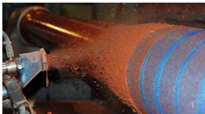
Applicering av fiberarmeradbetong (ZM-beläggning).
