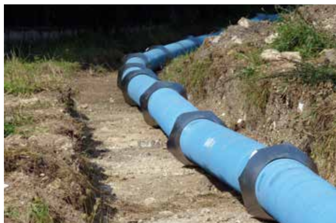
Avvinklingsmöjlighet upp till 5 ° innebär att behovet av rördelar kan minimeras.
